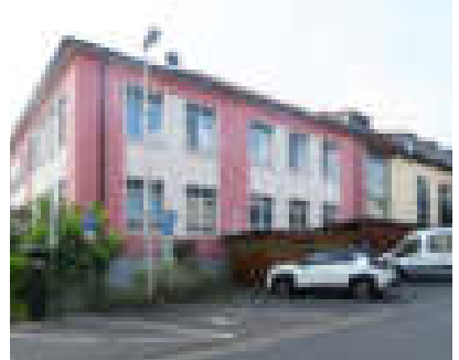
Abb.33: Pflegezentrum Obernburg, Lindenstraße 30 A
