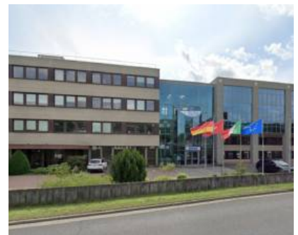
Abb.130: Maschinenbau- und Robotik-Unternehmen, Walter-Reis-Straße 1
