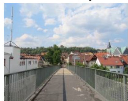
Abb.102: Fußgängerbrücke über den Main, Richtung Obernburg
