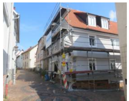
Abb.71: Untere Gasse 18, Baustelle
