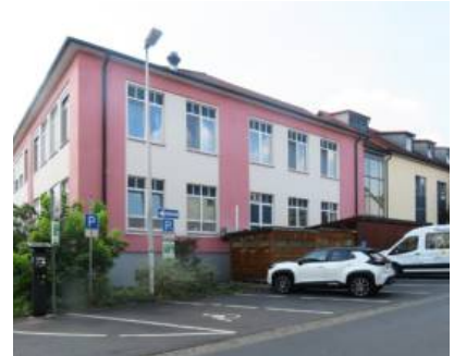
Abb.33: Pflegezentrum Obernburg, Lindenstraße 30 A
