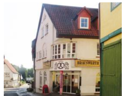
Abb.38: Bäckerei, Obere Gasse Quelle: Eigene Bestandsaufnahme
