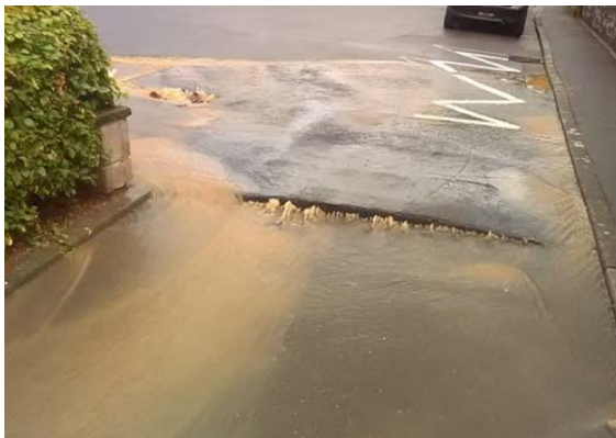
Abb. 1 - Wasserrohrbruch in der Sudetenstraße
