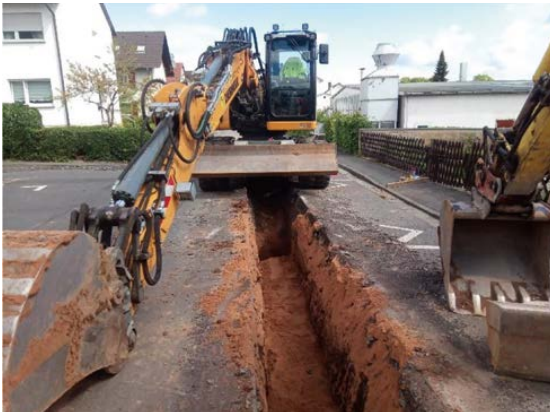
Abb. 3 - Verlegung des Rohrmaterials in ein Sandbett
